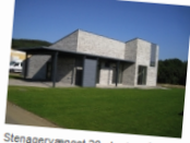
Stenagervej 25, der indgår i byggeriet Komfortusene i Skibet ved Vejle, er et eksempel på et lavenergihus, der lider af kraftig overophedning. I sommerperioden er temperaturen i stuen kun i komfortzonen 15-20 pct. af tiden.
